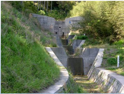
石原谷川 砂防堰堤詳細設計 (串間市大字西方)
