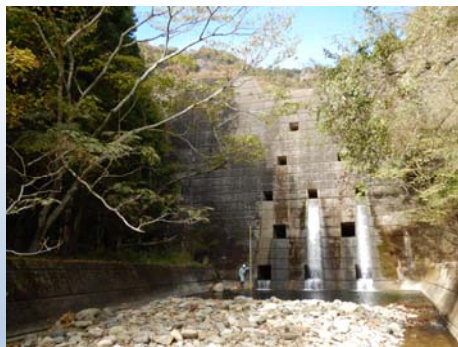
砂防施設調査
