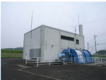
④佐賀県 排水機場の長寿命化
