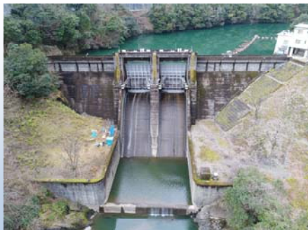
企業局 堤体コンクリート調査
