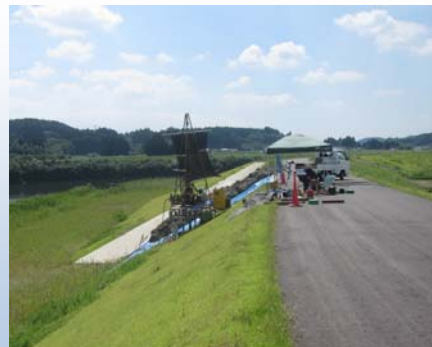
宮崎管内河川改修地質調査
