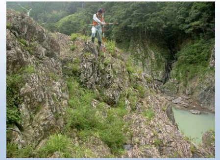
片内工区 ボーリング調査
