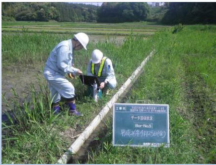
広瀬バイパス 水位観測
