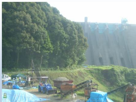
鶴田ダム下流法面 地質調査
