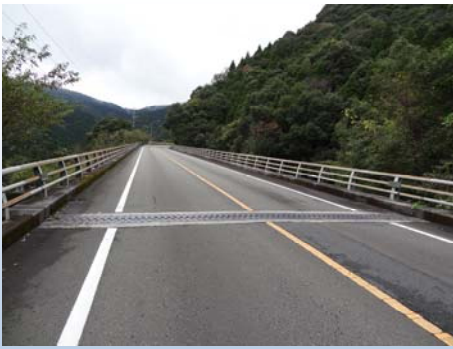
日南市 割籠谷橋
