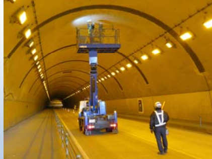
高岡町 トンネル点検
