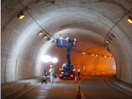
内海 トンネル点検
