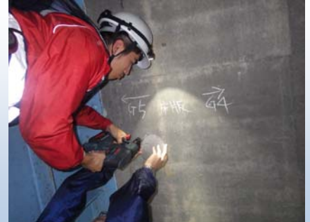
木花 橋梁詳細調査
