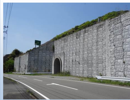
東九州自動車道 補強土壁設計
