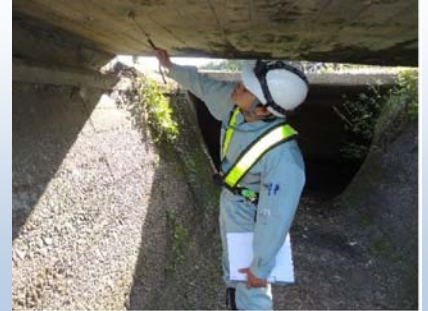
川南町 橋梁定期点検
