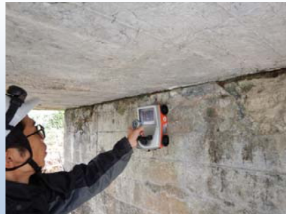
国富町 橋梁補修設計
