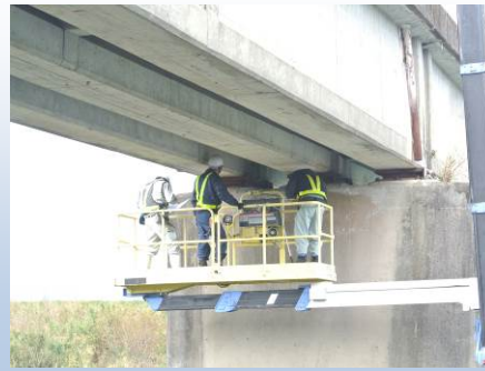
国道 219 号 橋梁定期点検
